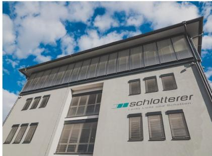
*2017 wurde das Verwaltungsgebäude um ein zusätzliches Stockwerk in Form einer Pfosten-Riegel-Konstruktion aus Aluminium und Glas ergänzt.*
